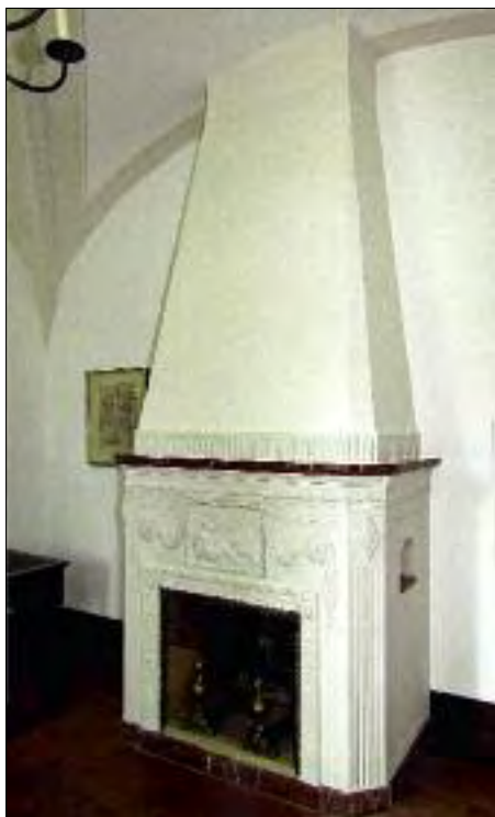
Der offene Kamin der nach den Erkenntnissen des reformerischen Grafen Rumford (1758 – 1814) gebaut wurde. Fotos: Albert Baumbach, Theodor Baumeister
